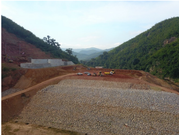
รูปที่ 1.6-2 ทำนบกั้นดินเขื่อนหลัก
